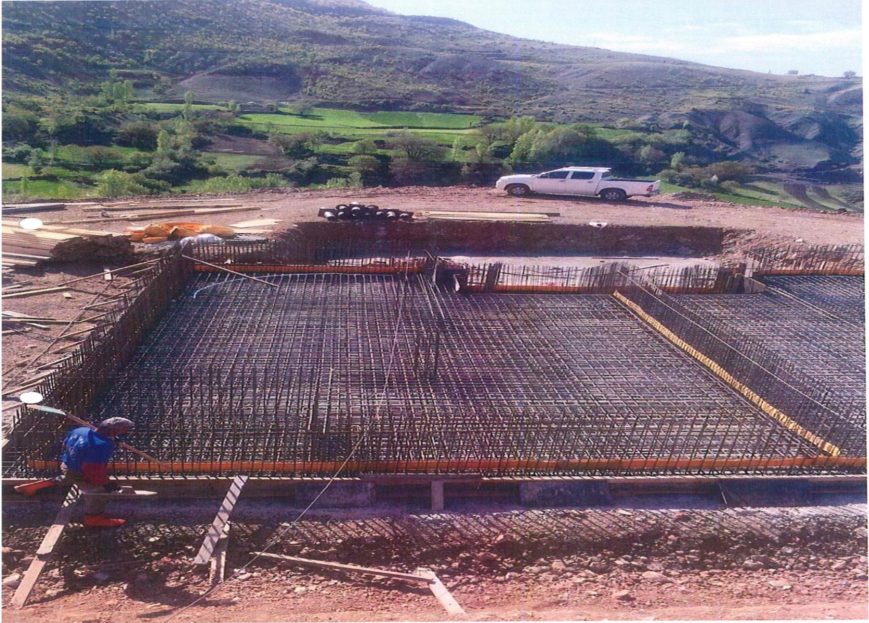
1-Arıcak İçmesuyu Tesisi
